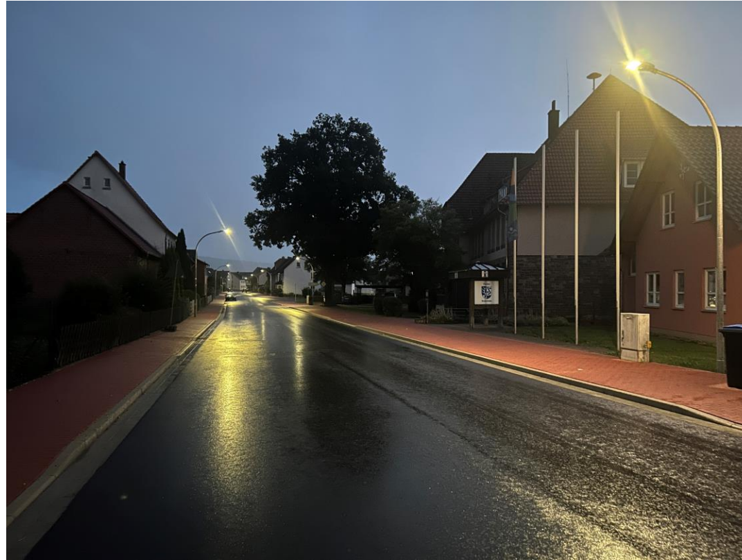
Straßenbeleuchtung Ortsdurchfahrt Bodenfelde – erster Bauabschnitt Inbetriebnahme 06.06.2025
